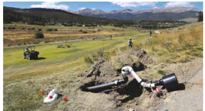
Die Modernisierung der veralteten Infrastruktur wird die Bedingungen auf dem Platz und die Arbeitseffizienz verbessern.
