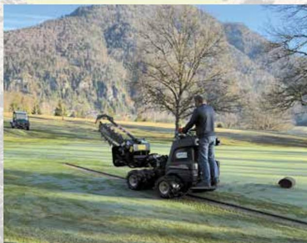
des Kieses ist unbedingt darauf zu achten, dass der Drain-Schlauch komplett eben am Boden aufliegt und dass keine Erhebungen entstehen, da ansonsten dort wieder die Gefahr von Wasserrückstau bzw. von Staunässe besteht.
